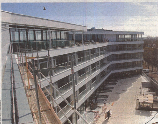
Na razie w obiekcie trwają ostatnie prace budowlane.
