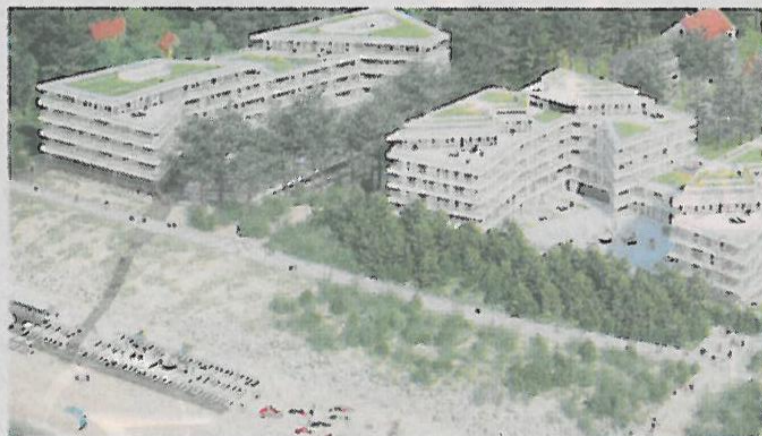
► Mieleński kompleks Dune widziany z lotu ptaka od strony Bałtyku. Gotowy jest obiekt z lewej strony. Budowany: z prawej
