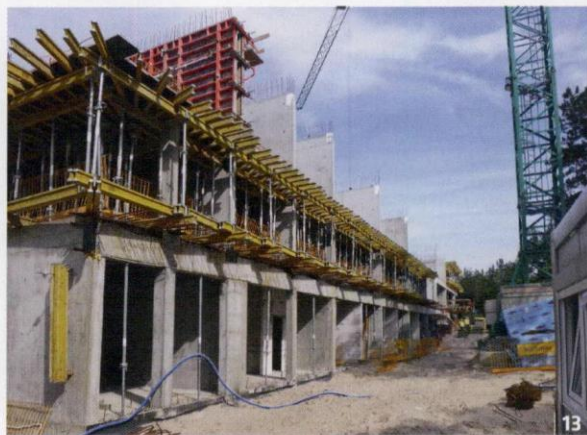
11-13 | W budynku zaprojektowano żelbetowe stropodachy i stropy monolityczne o grubości od 18 do 35 cm oraz ściany kondygnacji nadziemnych o grubości 24 cm
