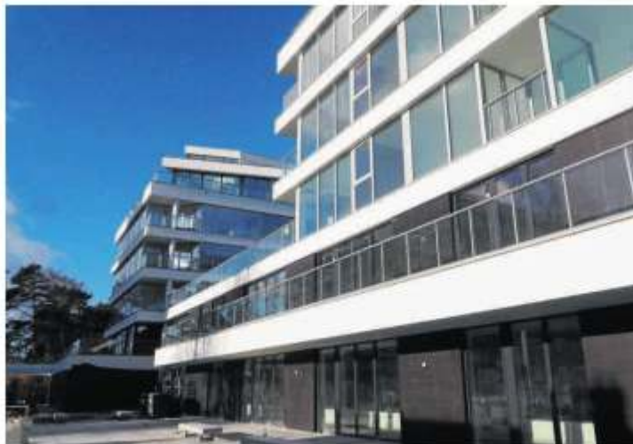
► Dune 2 z zewnątrz jest już gotowy, w środku trwają ostatnie prace wykończeniowe. To potężny obiekt z basenem, zapleczem którego łączna powierzchnia wynosi aż 12 tys. metrów kwadratowych
