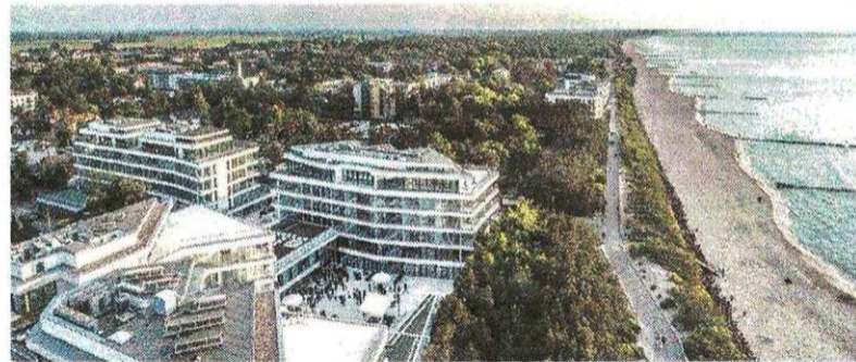
Wykonawcą wszystkich apartamentów w zespole Dune Resort był Budimex. Funkcję inwestora zastępczego i nadzoru budowlanego w imieniu dewelopera wypełniała firma Gleeds. Fot. Firmus Group
